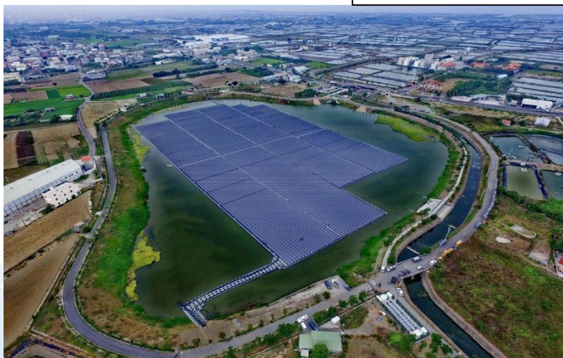
高雄永安滯洪池
